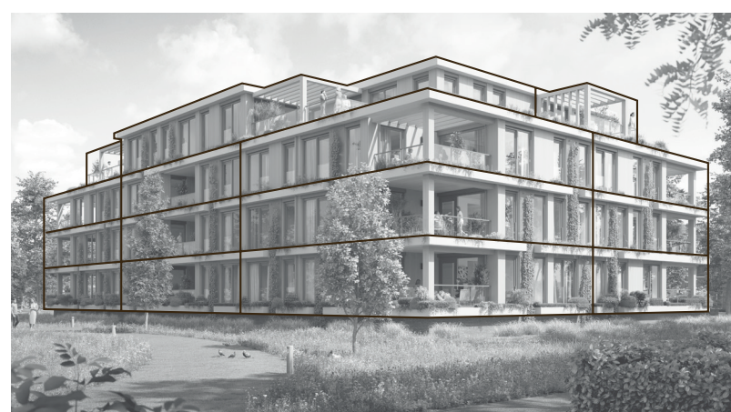
Achtergevel (westen) & linkerzijgevel (zuiden)
