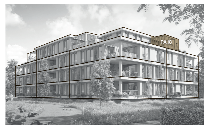
Achtergevel (westen) & linkerzijgevel (zuiden)
