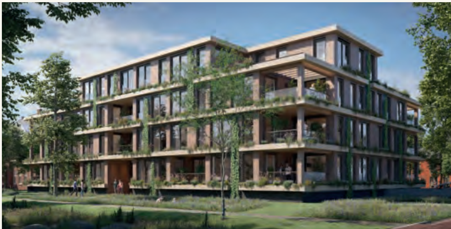
Voorgevel (oosten) & rechterzijgevel (noorden)
