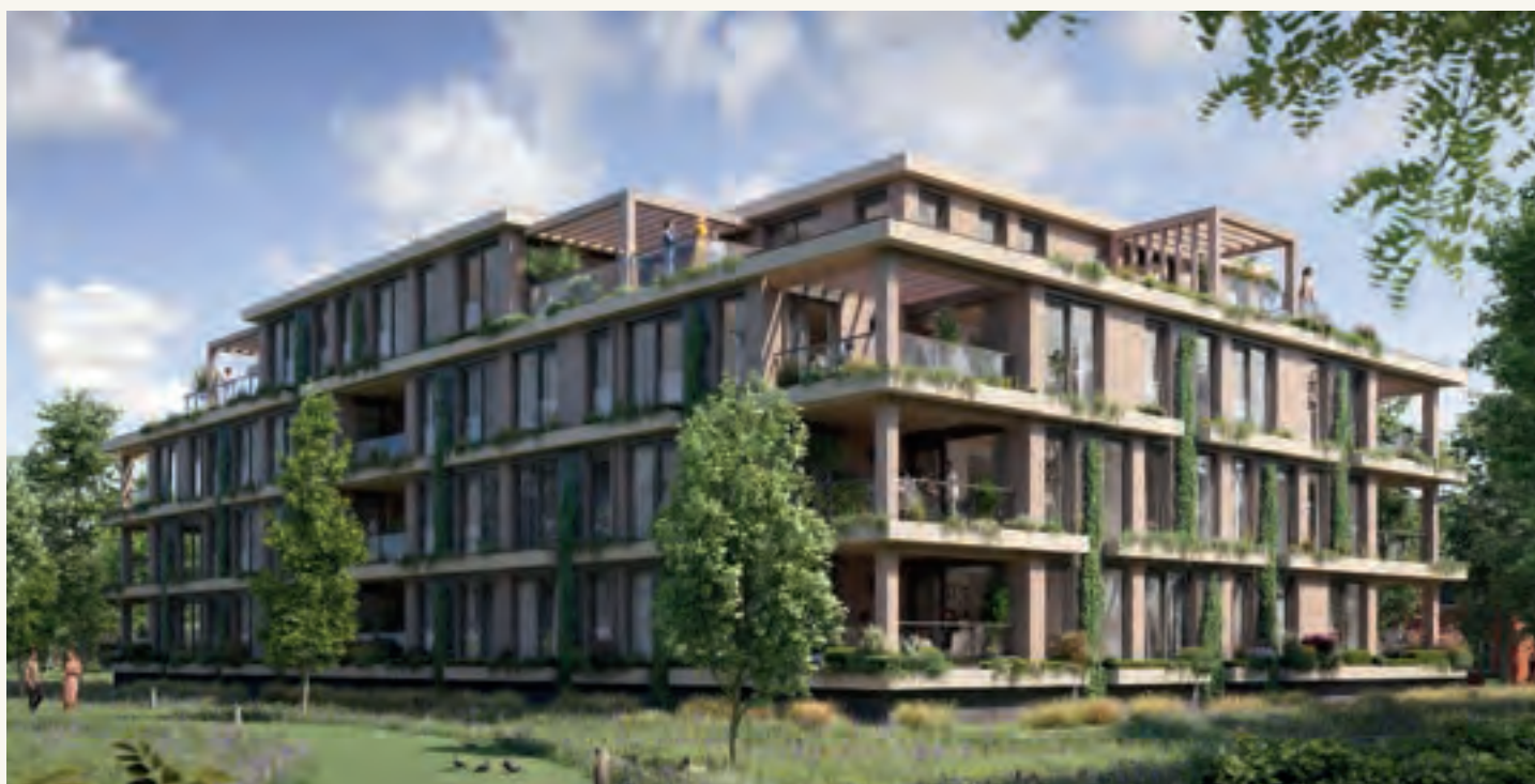
Achtergevel (westen) & linkerzijgevel (zuiden)
